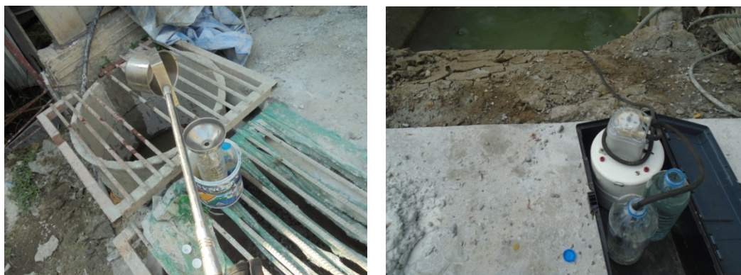
จุดเก็บตัวอย่างน้ำทิ้งบ่อพักน้ำทิ้ง พื้นที่โครงการ และบ้านพักคนงาน
