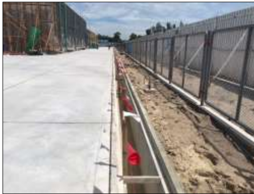
รูปภาพคูรางระบายน้ำ
