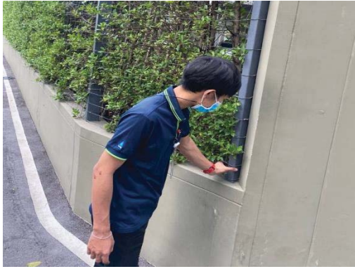
ภาพที่ 3.4-1 การตรวจสอบรั้วโครงการ
