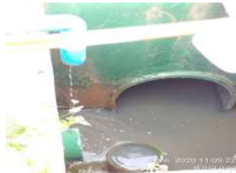
รูปที่ 7 ถังบำบัดน้ำเสียสำเร็จรูป
