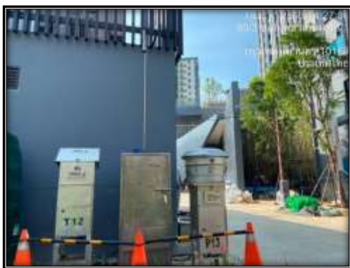
บริเวณพื้นที่ก่อสร้างของโครงการ
