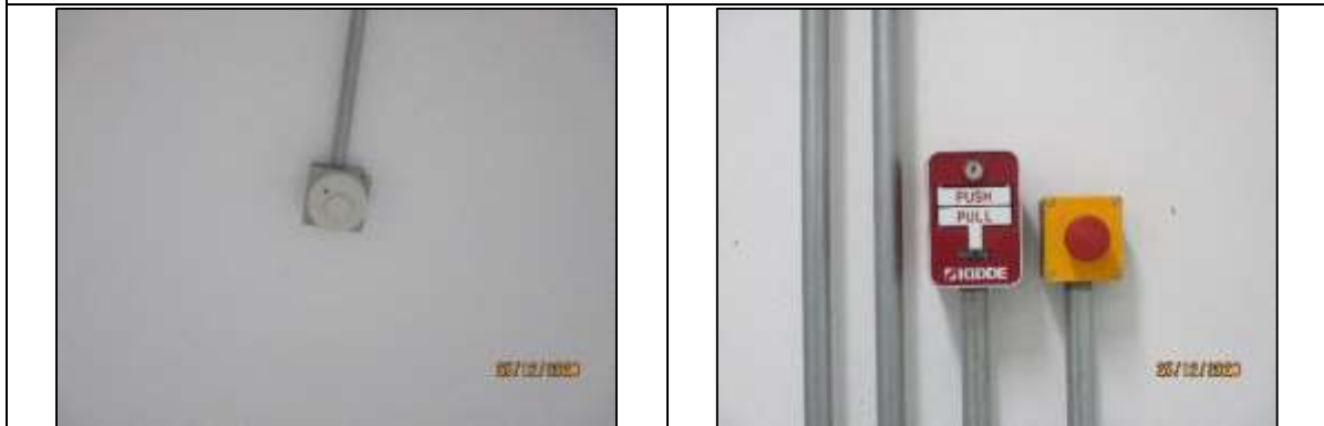
รูปที่ 2-10 ปุ่มกดขอความช่วยเหลือฉุกเฉินภายในห้องควบคุม
