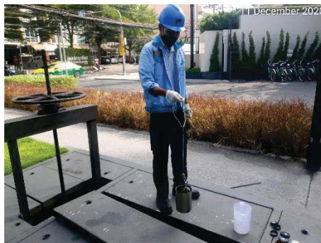
บ่อพักน้ำสุดท้ายของระบบระบายน้ำ
