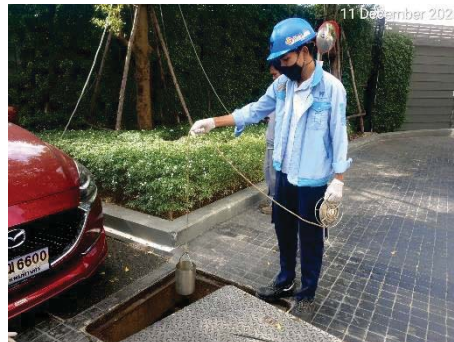
น้ำหลังผ่านระบบบำบัดน้ำเสีย ชุดที่ 3
