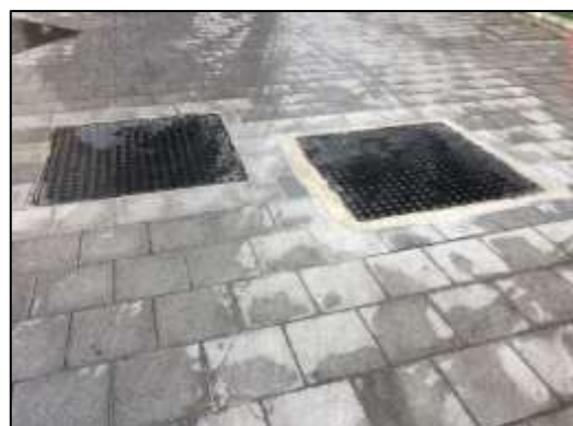
ภาพที่ 43 ระบบบำบัดน้ำเสีย
