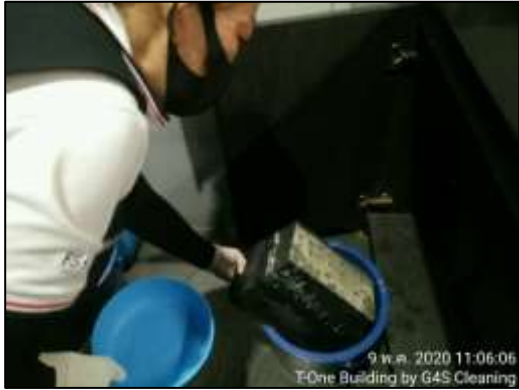
ภาพที่ 25 พนักงานทำความสะอาดตะกอนส่วนเกิน และตัดไขมัน
