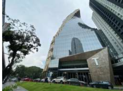
ภาพที่ 45 สภาพโครงการปัจจุบัน
