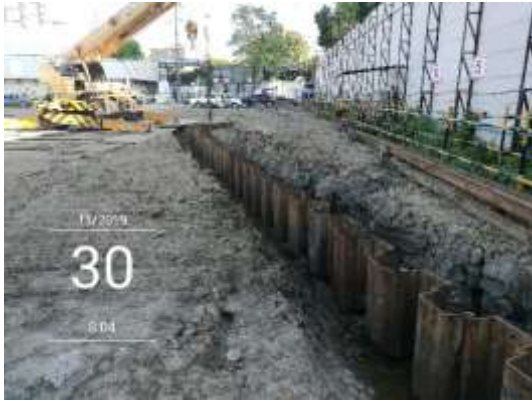
Sheet Pile 1 ชั้น บริเวณชั้นดินอ่อนรอบพื้นที่ก่อสร้างโครงสร้างใต้ดิน
