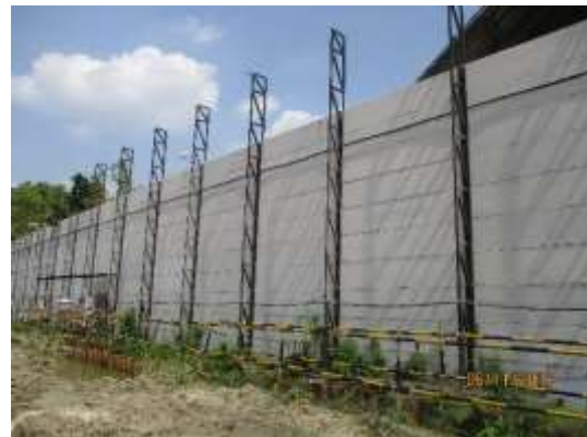
การติดตั้งแผ่นผนัง BB (BB WALL PANEL)
