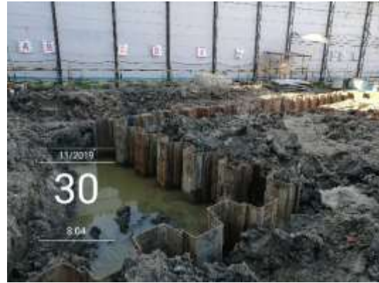
Sheet Pile 1 ชั้น บริเวณชั้นดินอ่อนรอบพื้นที่ก่อสร้างโครงสร้างใต้ดิน
