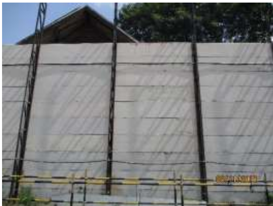
การติดตั้งแผ่นผนัง BB (BB WALL PANEL)
