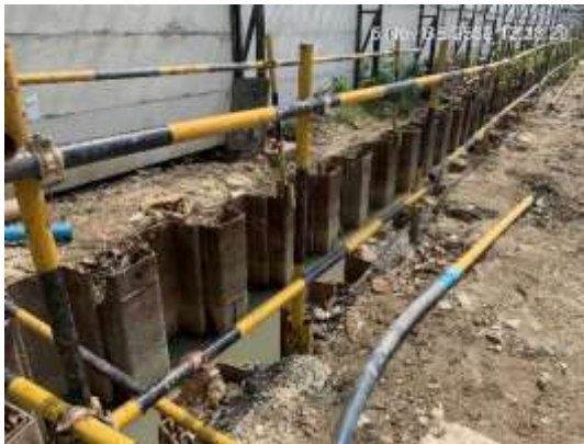
ติดตั้ง Sheet Pile 2 ชั้น ยาว 8 เมตร (ติดตั้งชั่วคราว) และยาว 16 เมตร (ชั้นนอกสุดติดตั้งถาวร) บริเวณด้านทิศตะวันออกและทิศใต้ที่อยู่ติดกับพระตำหนักปลายเนิน
