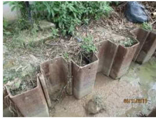
ติดตั้ง Sheet Pile 2 ชั้น ยาว 8 เมตร (ติดตั้งชั่วคราว) และยาว 16 เมตร (ชั้นนอกสุดติดตั้งถาวร) บริเวณด้านทิศตะวันออกและทิศใต้ที่อยู่ติดกับพระตำหนักปลายเนิน
