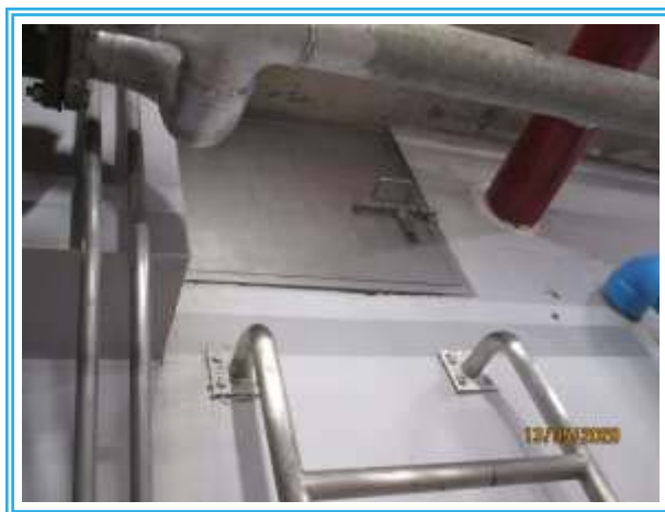
รูปที่ 2.4-4 ถังเก็บน้ำใต้ดิน
