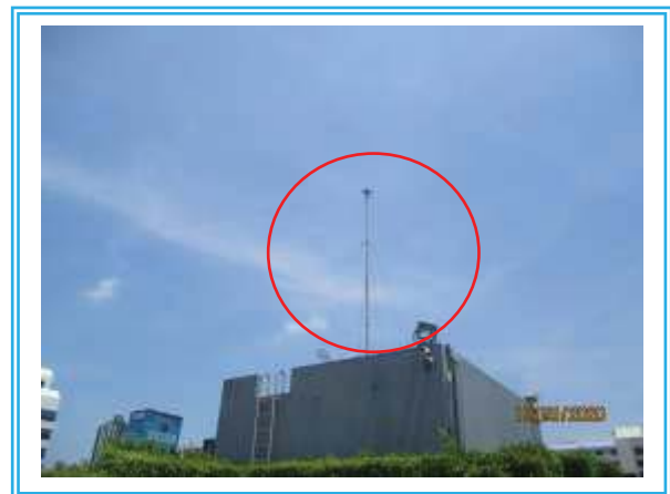
รูปที่ 2.4-11 ระบบป้องกันฟ้าผ่าแบบเสาหล่อฟ้า
