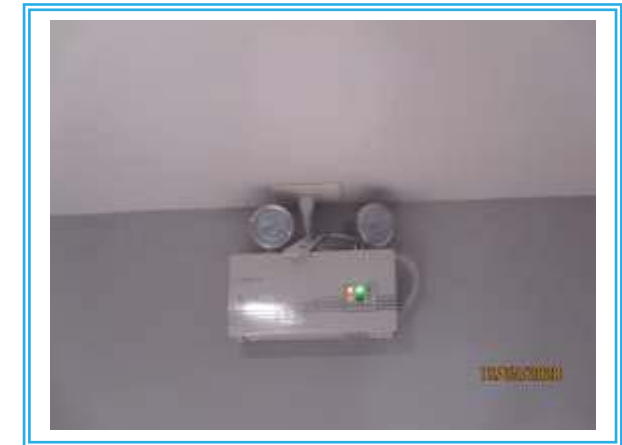
รูปที่ 2.4-17 ไฟส่องสว่างฉุกเฉิน
