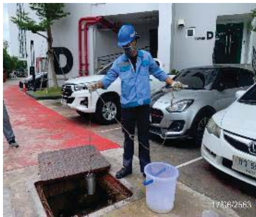
น้ำก่อนเข้าระบบบำบัดน้ำเสีย ชุดที่ 2
