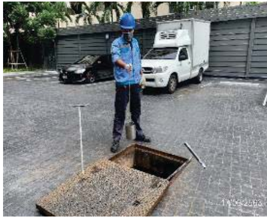
น้ำก่อนเข้าระบบบำบัดน้ำเสีย ชุดที่ 1
