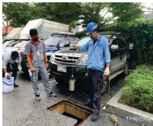
น้ำหลังผ่านระบบบำบัดน้ำเสีย ชุดที่ 3
