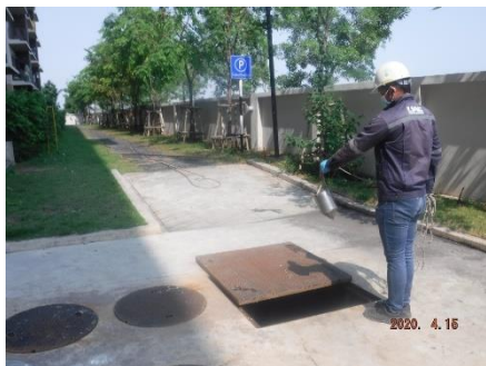
อาคารที่พักอาศัย R04
