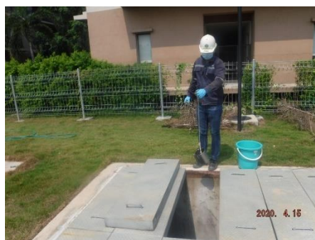
บ่อตรวจสอบคุณภาพน้ำทิ้งก่อนระบายออกจากโครงการ
