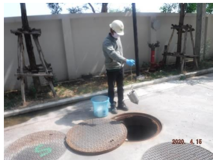
อาคารที่พักอาศัย R05
