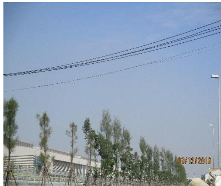
รูปที่ 1-4 สภาพโดยทั่วไป บริเวณศูนย์ซ่อมบำรุงและควบคุมการเดินรถ
