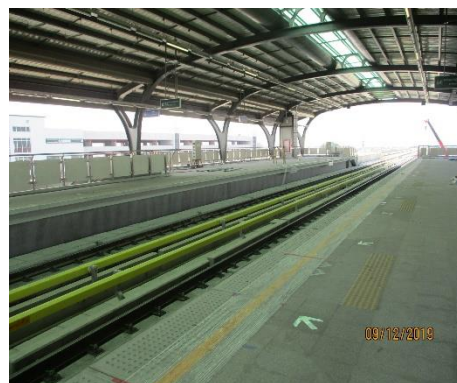
บริเวณชั้นชานชาลา (Platform Level)
