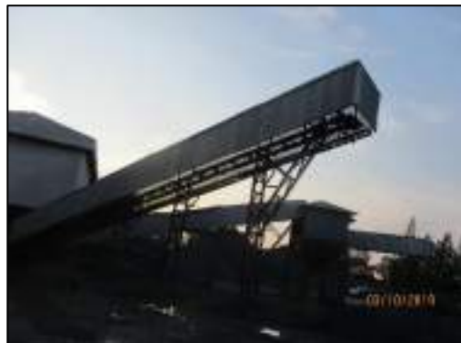
รูปที่ 2-6 การติดตั้งระบบสายพานลำเลียงระบบปิด เพื่อป้องกันและกำจัดฝุ่นละออง
