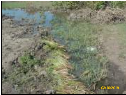
รูปที่ 2-17 การปลูกพืชคลุมดินหรือหญ้าแฝก บริเวณคั่นทำนบดิน และแนวขอบพื้นที่โครงการ เพื่อป้องกันการชะล้างหน้าดิน
