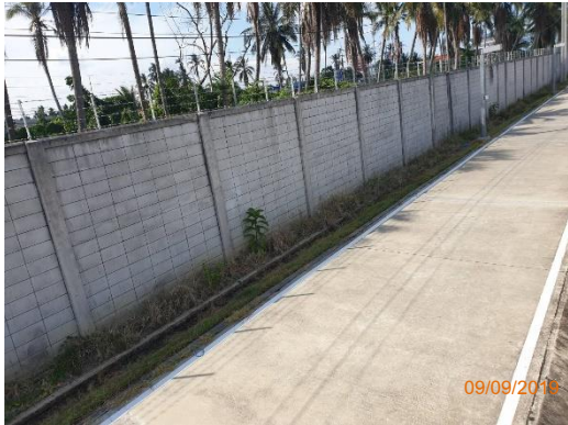
รูปที่ 2-6 รั้วทึบสูง 2 เมตร และถนนคอนกรีต บริเวณศูนย์ซ่อมบำรุง
