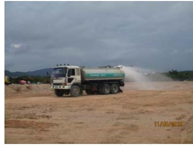
ภาพที่ 2-2 การฉีดพรมน้ำในพื้นที่ก่อสร้าง
