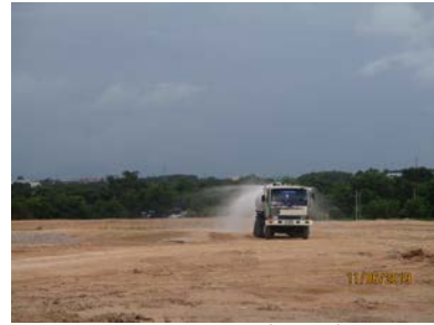
ภาพที่ 2-2 การฉีดพรมน้ำในพื้นที่ก่อสร้าง
