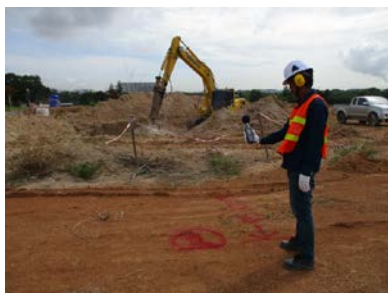
ภาพที่ 2-11 การตรวจวัดเสียงจากแหล่งกำเนิดขณะที่มีกิจกรรมก่อสร้าง
