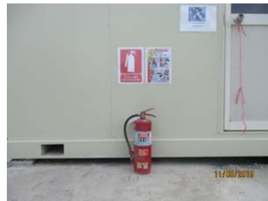
ภาพที่ 2-26 ถังดับเพลิง
