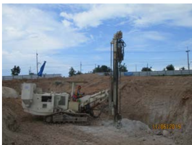
ภาพที่ 2-29 การปฏิบัติงานเจาะและงานขุด
