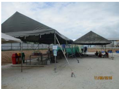
ภาพที่ 2-20 สถานที่พักสำหรับให้คนงาน ในช่วงเวลากลางวัน
