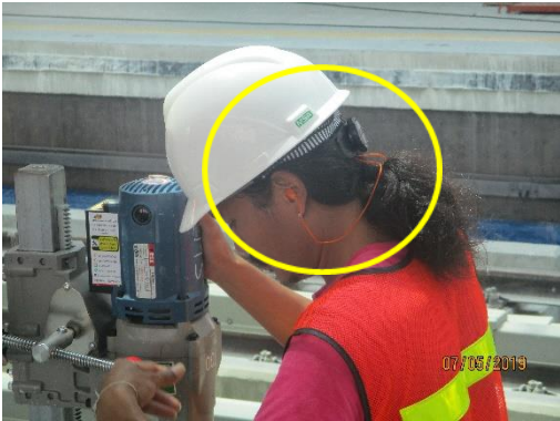
รูปที่ 2-8 จัดเตรียมอุปกรณ์ป้องกันเสียงดัง
