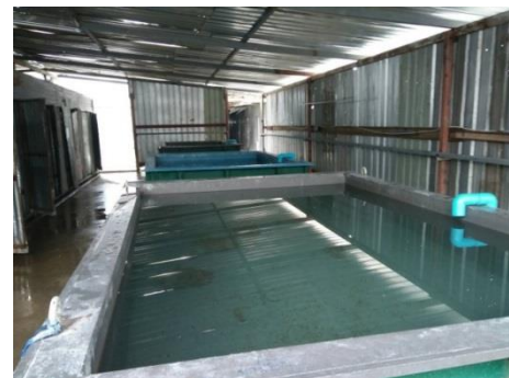
ภาพที่ 2.2-13 ลานชำระล้างและห้องน้ำ บริเวณบ้านพักคนงาน
