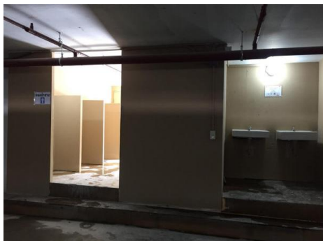
ภาพที่ 2.2-12 ห้องน้ำคนงานบริเวณพื้นที่โครงการ
